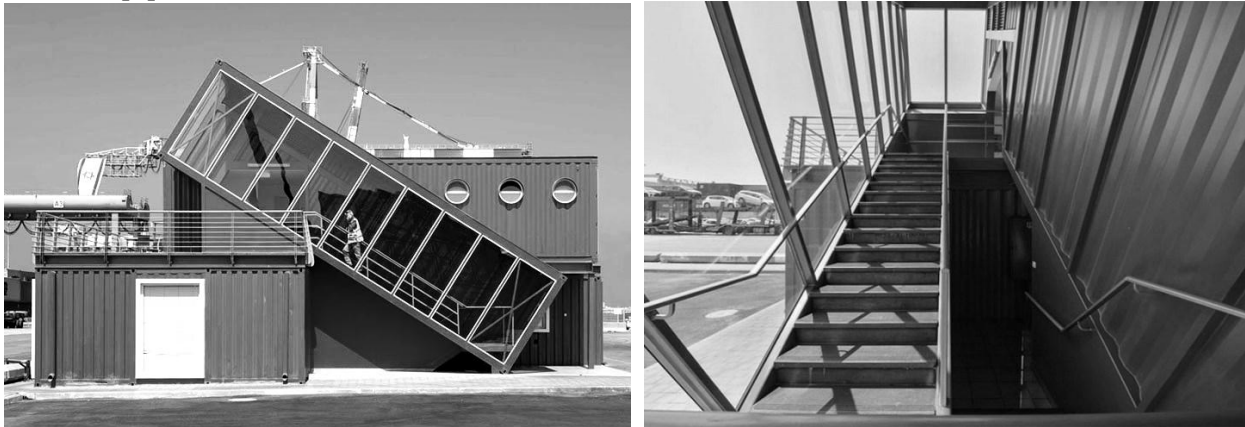
Рис. 3. Офісна будівля з 7 вантажних корабельних контейнерів (контейнер зі сходами розміщений під кутом 30 градусів) в порту Ашдод (в 30 кілометрах від Тель-Авіва); дизайн-студія «Potash Architects» [7]
