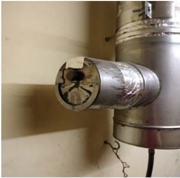
Рис. 2. Пасивний регулятор тяги
