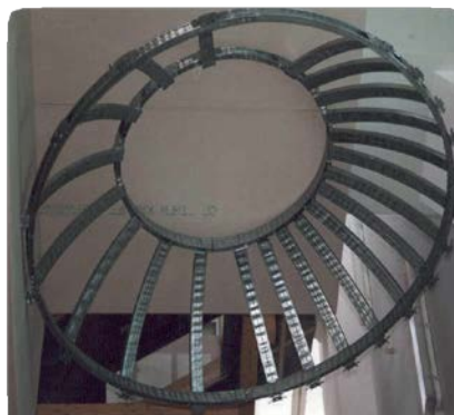
Мал. 6.42. Приклад каркаса склепіння усіченої сферичної форми
