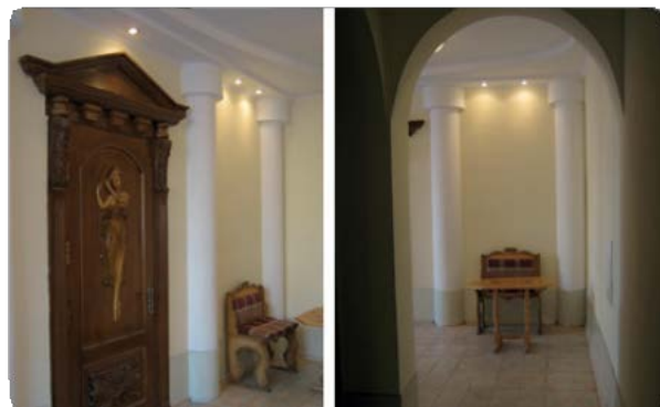
Мал. 6.26. Приклад оформлення інтер'єру коридору напівколони, виготовленими з гіпсокартонного елемента малого радіуса працівниками НПБЦ Кнауф ТВПУДТ
