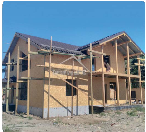
Мал. 3.27. Б. Обшивка фасаду каркасного будинку з дерев'яних елементів великорозмірними плитами
