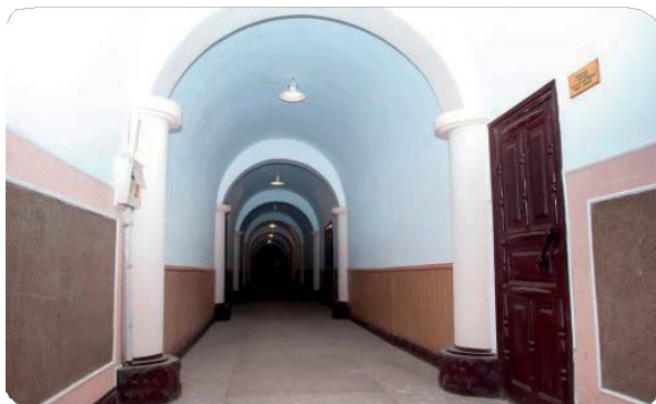
Мал. 6.34. А. Дизайн підвісної стелі у вигляді циліндричного склепіння коридору з гіпсокартонними елементами великого радіуса. ВПУ №2 м. Херсон. 2006 р.
