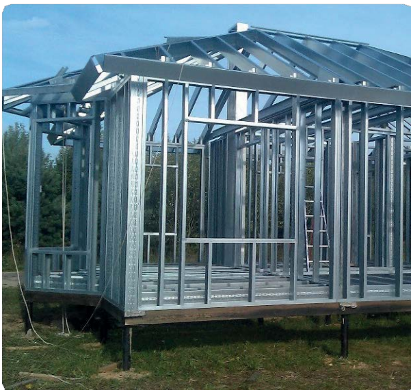
Мал. 3.44. Просторовий каркас житлового будинку, змонтований із заздалегідь виготовлених панелей плоских каркасів з ЛСТК
