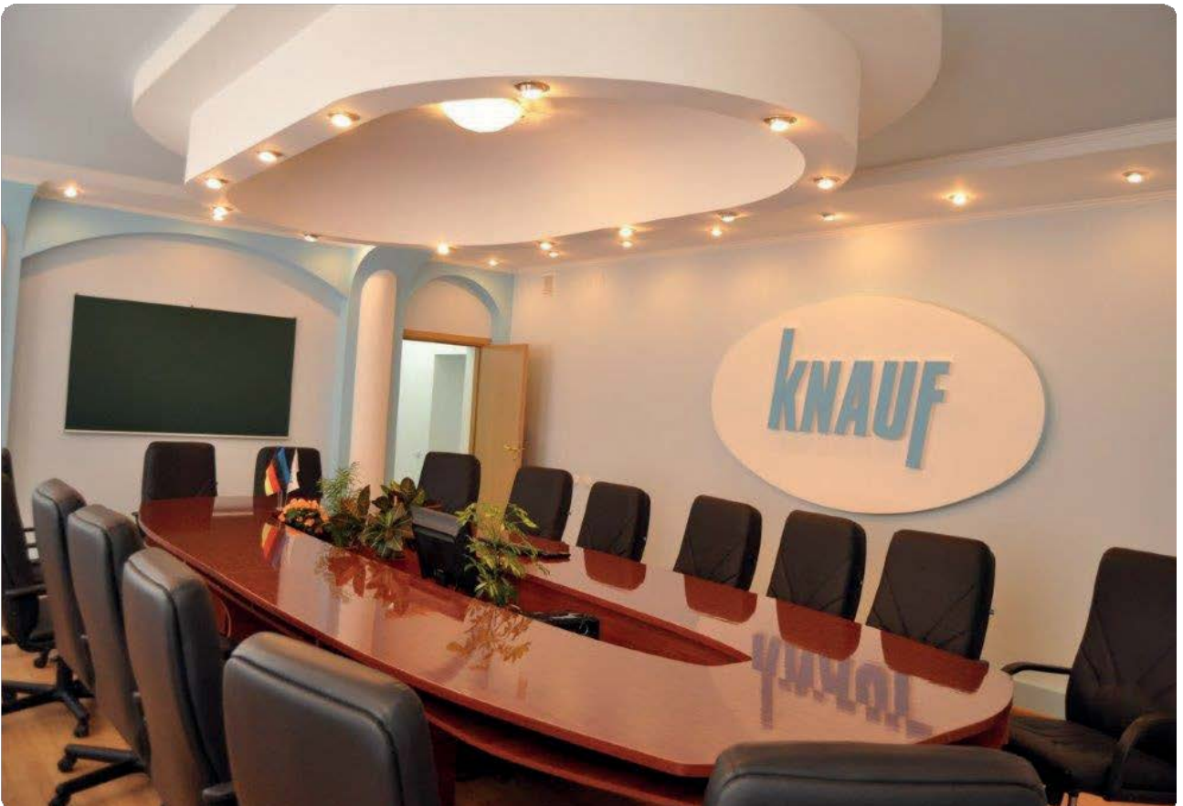
Мал. 6.33. А, Б. Фрагменти змонтованої гіпсокартонної різнорівневої підвісної стелі з улаштованим в центрі: а – зворотним склепінням усіченої еліптичної форми; б – склепінням еліптичної форми
