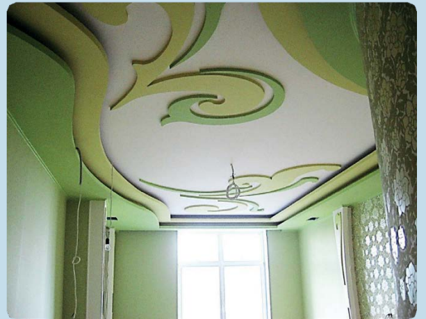
Мал. 2.44. Спосіб накладання декоративних елементів (гіпсорельєфів) на гіпсокартонну основу
