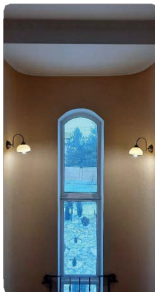
Мал. 6.9. Приклад еркера, вимуруваного з цегли та обшитого з середини гіпсокартонною обшивкою у вигляді двоцентрової арки
