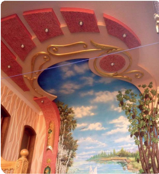
Мал. 2.31. А. Приміщення вітальні з поєднанням площини стелі і однієї стіни у вигляді суцільного полотна, виконаного з криволінійних гіпсокартонних елементів великого радіуса
