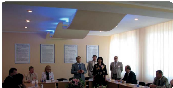
Мал. 6.19. Дизайн підвісної стелі з декоративними хвилеподібними гіпсокартонними елементами. ОПЛБА. Робота працівників НПБЦ Кнауф. 2006 р.
