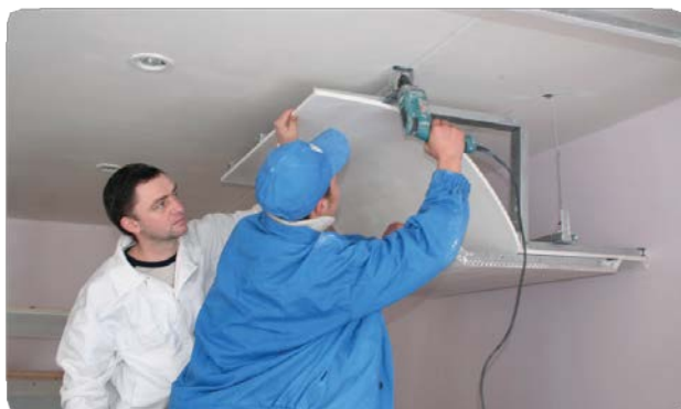
Мал. 6.48. Монтаж фрагмента комбінованого облицювання карниза дворівневої підвісної стелі з поєднанням круглих і ламаних гіпсокартонних поверхонь. НПБЦ Кнауф КЦППРКБА. 2006 р.
