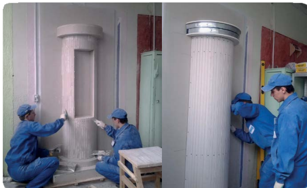
Мал. 6.25. Випускники будівельних училищ виготовляють пристінну конструкцію півколони з використанням гіпсокартонного елемента малого радіуса
