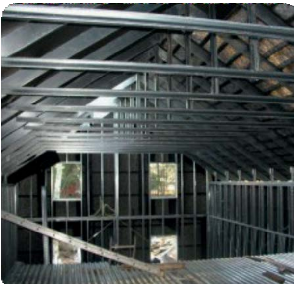
Мал. 3.41. А. Монтаж каркаса будинку з улаштуванням горизонтального приміщення методом поелементного збирання
