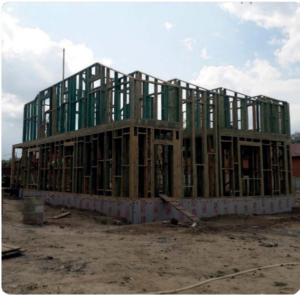
Мал. 3.27. А. Зведення каркаса будинку з дерев'яних елементів
