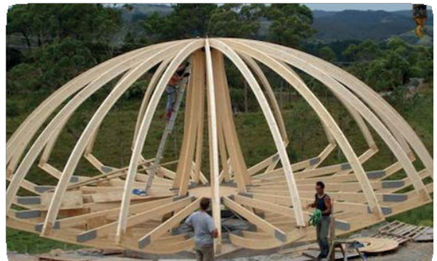
Мал. 6.28. Монтажні роботи з улаштування каркаса купола-парасольки з рівномірно розташованими дерев'яними ребрами
