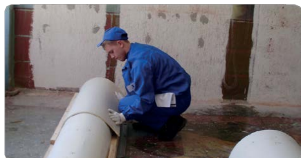
Мал. 6.16. Майстер-клас «Створення гнутих гіпсокартонних конструкцій великого радіуса заокруглення на шаблоні без перфорування». НПБЦ Кнауф. Львів. 2012 р.
