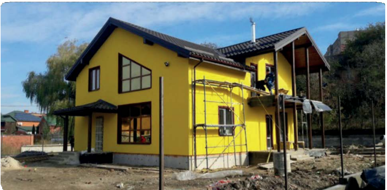
Мал. 3.27. В. Остаточне опорядження фасаду будинку з дерев'яним каркасом
