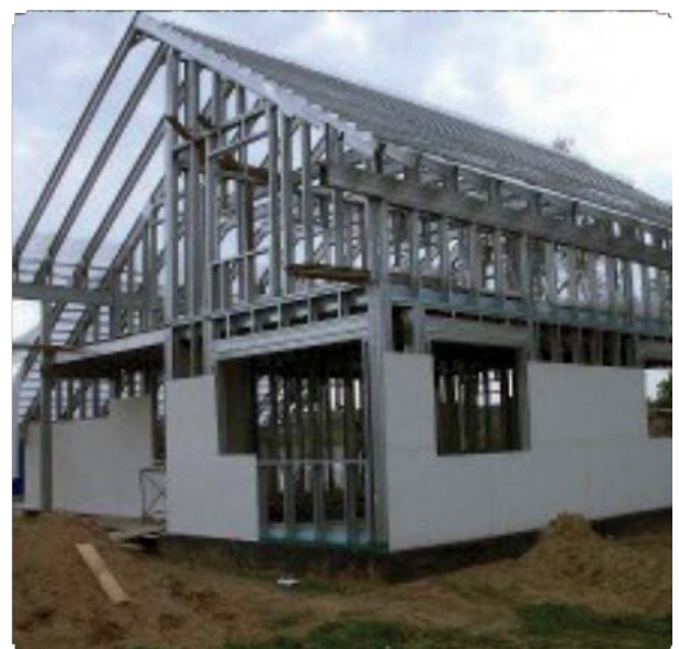
Мал. 3.41. Б. Обшивка змонтованого каркасного будинку плитами Аквапанель зовнішня
