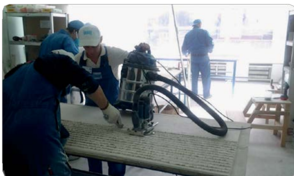
Мал. 6.23. Нарізування П-подібних паралельних пазів за допомогою спеціального фрезерувального пристрою з пиловсмоктувачем. Міжнародний конкурс монтажників гіпсокартонних конструкцій. ЛВПУБД. Львів. 2013 р.
