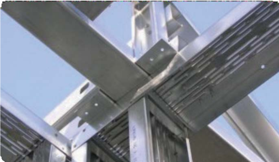
Мал. 3.40. Вузол з'єднання металевих елементів плоских каркасів
