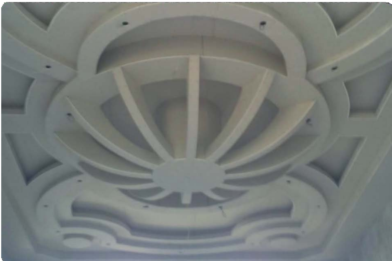
Мал. 6.32. А. Фрагмент плаского сферичного склепіння випуклої форми з окремих ребристих гіпсокартонних елементів
