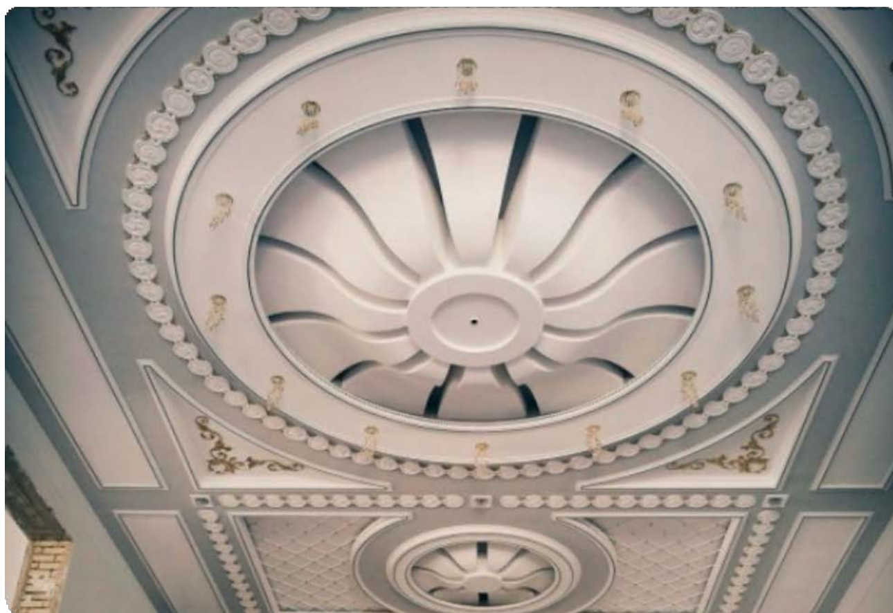
Мал. 6.32. Б, В. Фрагменти плоского сферичного склепіння випуклої форми з окремих листових гіпсокартонних елементів
