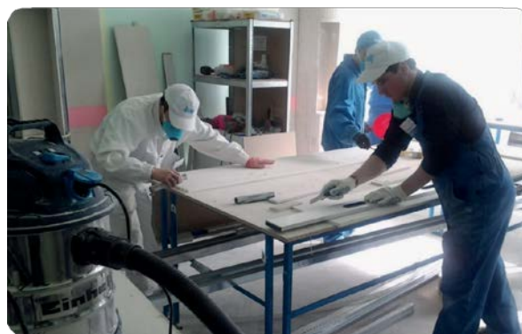
Мал. 6.24. Нарізування П-подібних паралельних пазів уручну. Міжнародний конкурс монтажників гіпсокартонних конструкцій. ЛВПУБД. Львів. 2013 р.
