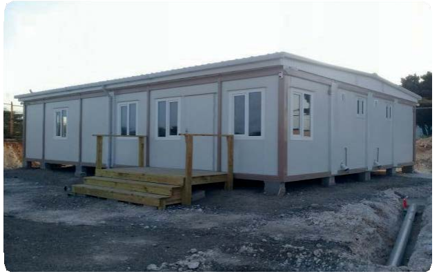
Г. Офіси аеропорту, Ораньєстад, Аруба
