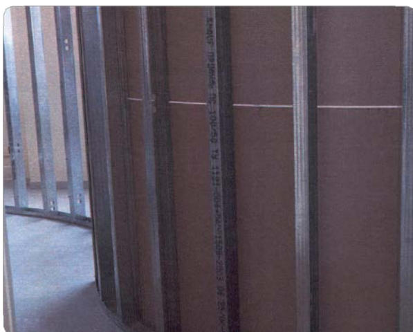
Мал. 6.1. А. Каркас криволінійної S-подібної перегородки
