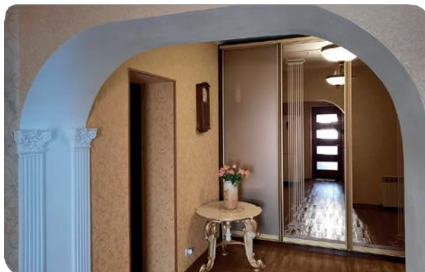
Мал. 6.8. Оформлення дверного прорізу в стіні житлового будинку у вигляді двоцентрової арки з використанням гіпсової суміші Кнауф-Ротбанд, виготовленої автором посібника Тетяною Остапченко
