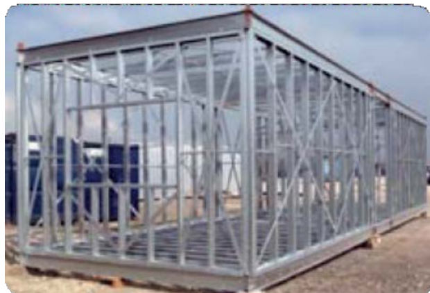
Мал. 3.47. Монтаж каркаса будинку з улаштуванням горищного приміщення методом поелементного збирання
